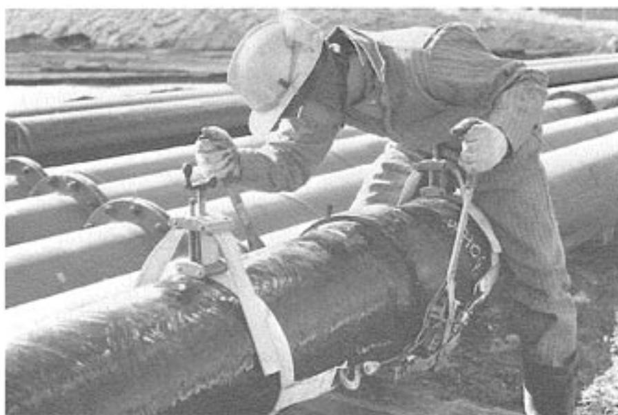
*Lubrifier le jonc de blocage (fourni par Ameron) avant l'insertion. Selon les données du projet, on peut utiliser des joncs métalliques ou plastiques.*
