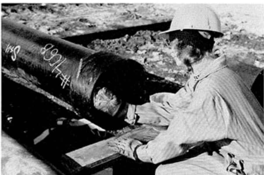
*L'extrémité mâle du tube à insérer doit également être amplement lubrifiée. S'assurer à nouveau que la rainure assurant le passage du jonc de blocage est bien lubrifiée.*
