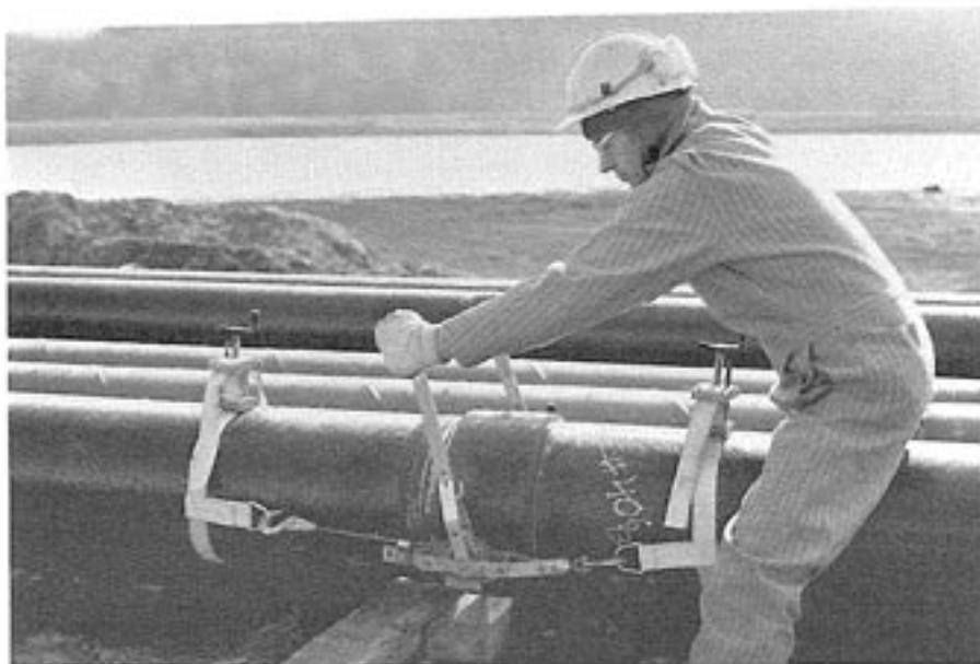
*Insérer l'extrémité mâle jusqu'à ce que la ligne repère soit située à environ 6 mm (1/4") du bord d'attaque de la tulipe ou du manchon.*
