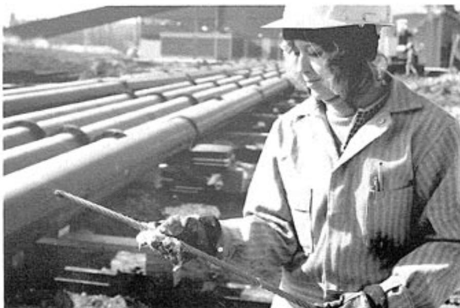
*Introduire le jonc de blocage lubrifié dans l'orifice d'insertion et poursuivre lentement l'avance de l'extrémité mâle jusqu'à ce que le jonc s'engage avec facilité dans le chemin de blocage.
