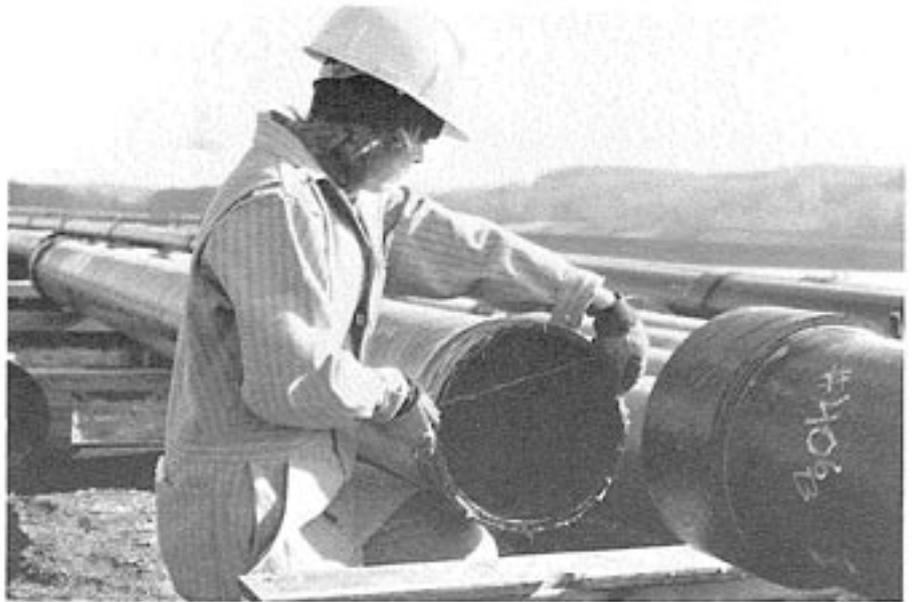
*Monter les cercles de serrage (disponibles chez Ameron), à une distance convenable de chaque côté du joint en s'assurant que le tube à insérer est correctement positionné pour assurer une insertion du jonc de blocage du joint suivant.*
