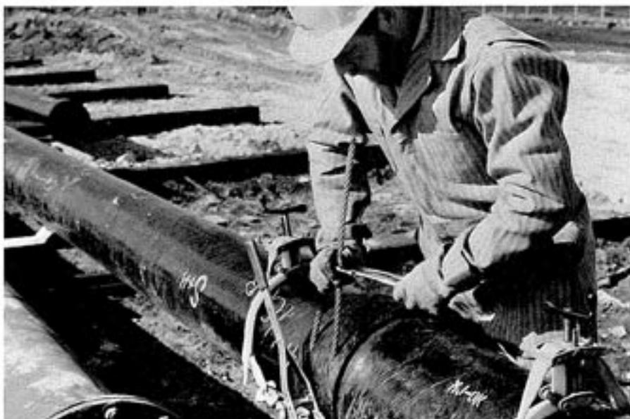
*Grâce à la possibilité de réutilisation offerte par les systèmes de joints mécaniques Key-Lock, cette conduite d'eau de rejet peut être aisément agrandie ou déplacée dans le futur.*
