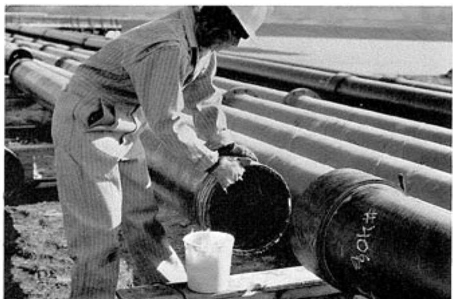
*Après avoir revêtu le joint O'ring (fourni par Ameron) de lubrifiant, le mettre en place dans la rainure à proximité immédiate de l'extrémité mâle du tube. Insérer un tournevis sous le O'ring en place et le faire tourner tout autour du tube pour bien répartir le joint O'ring dans la rainure.*
