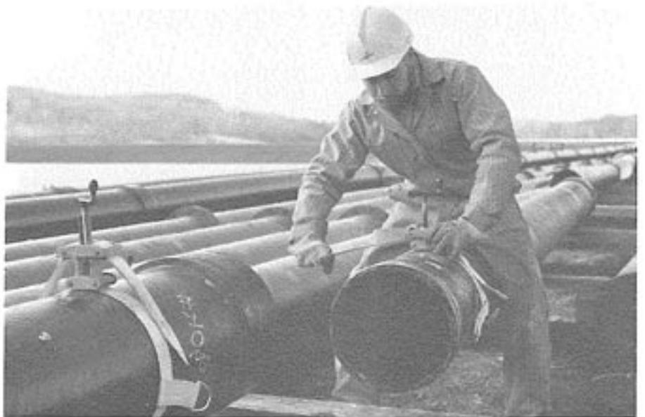
*Aligner le tube pour permettre une introduction parfaitement axée. Un alignement correct est une condition essentielle pour un assemblage aisé.*
