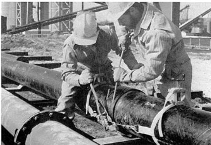
*Enfoncer le jonc de blocage jusqu'à ce que l'extrémité de tête réapparaisse au niveau de l'orifice d'insertion, et pas plus loin. Sinon, il risque de se coincer, rendant difficile ou impossible toute opération ultérieure de démontage.*
