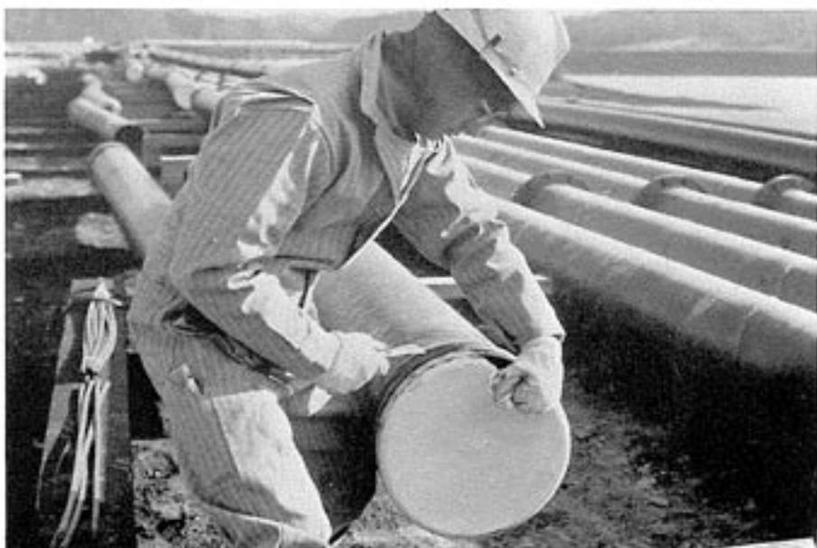
*Lubrifier l'intérieur de l'extrémité femelle et la rainure de blocage avec une quantité suffisante de lubrifiant (disponible sur commande chez Ameron). S'assurer que le tube déjà en place a été correctement tourné, de façon que l'orifice d'insertion du jonc de blocage soit convenablement positionné par le joint suivant.*
